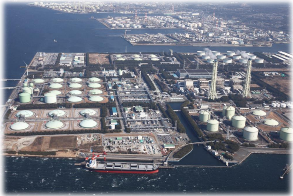
Sodegaura Thermal Power Plant & LNG Terminal
